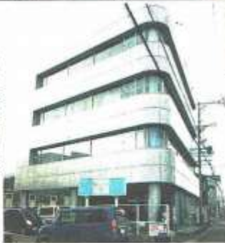
アジア共栄事業協同組合が入るビル。22日、愛知県一宮市で。
